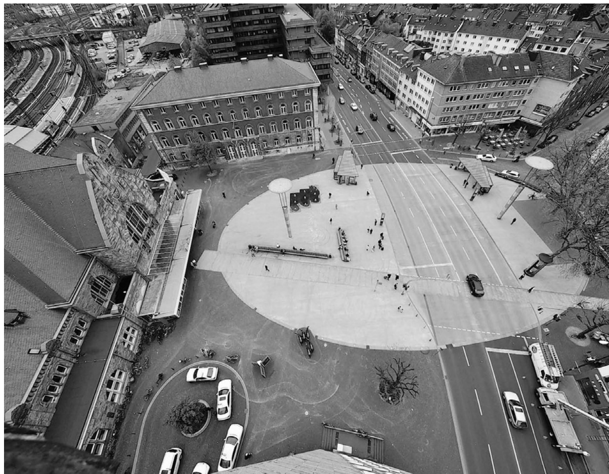
Nach fünf Jahren ein Sanierungsfall: der Bahnhofsvorplatz. 200 000 Euro müssen für eine Drainage und mehr Barrierefreiheit ausgegeben werden. Archivfoto: Andreas Herrmann
